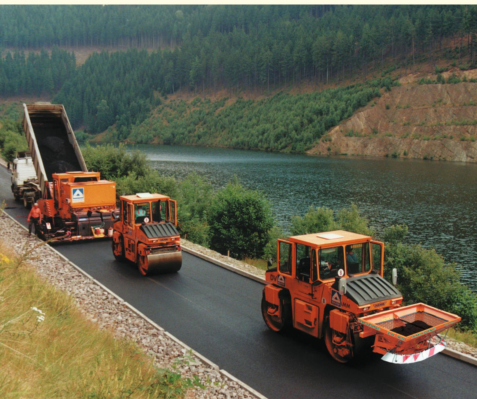
Der Anbaustreuer ZA-XS H ist speziell für den Straßenbau konstruiert. Dank seines Hydraulikantriebes eignet sich der Zweischeibenstreuer ideal für Straßenwalzen, die gleichzeitig die Fahrbahn mit Splitt abstumpfen. Die stabile Bauweise des ZA-XS H sorgt zudem für einen langlebigen Betrieb des AMAZONE Streuers.
